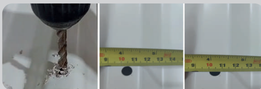
Pre perforación del perfil (zona cresta)
