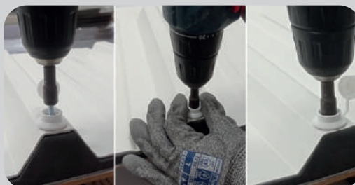
Instalación del set de fijación Klar
