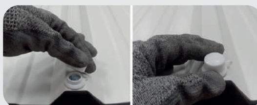
Instalación del set de fijación Klar
